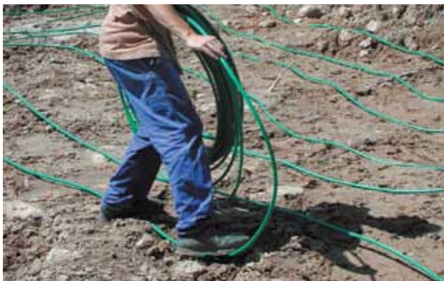
Pose de capteurs horizontaux.
